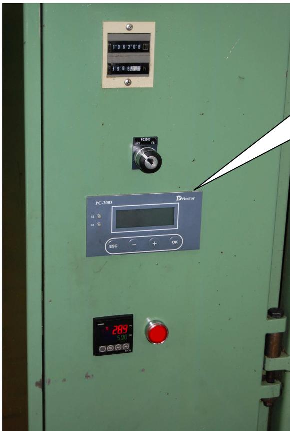
Beispiel für in einem Schaltschrank integrierte Auswerteeinheit PC2003
